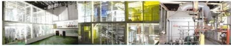
6TPD机械炉排式垃圾焚烧中试线
